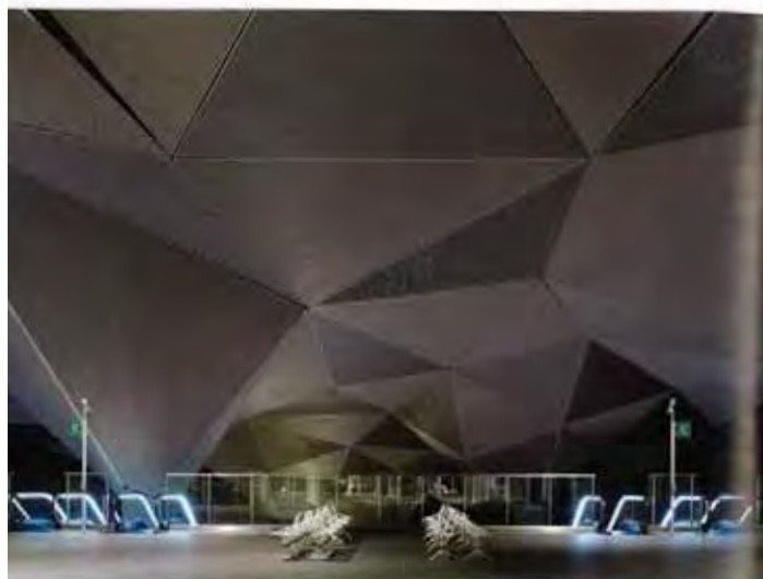
Arriba, cubierta de la estación de tren de alta velocidad de Logroño, integrada por lamas de aluminio extruido de CORTIZO
